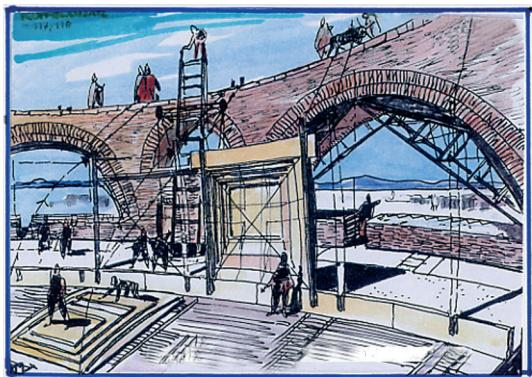
Abb. 16: ... und von innen: Beginn der Montage Kuppelschalung.
