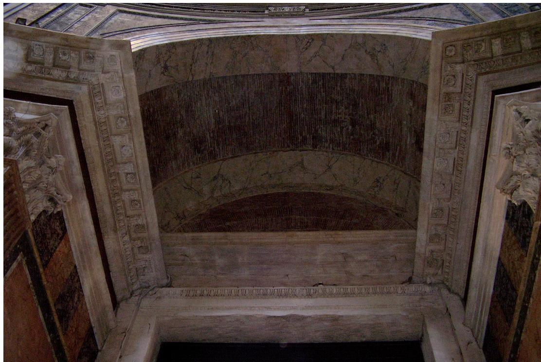
Abb. 17: Pantheon. Hyperthyron von der Innenseite der Tür zur Rotunde (Foto J. Albers).
